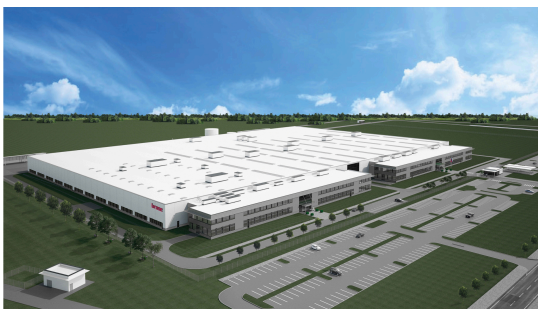
Die erste Baustufe in Pančevo umfasst 60.000 Quadratmeter Fertigungs- und Verwaltungsfläche.
