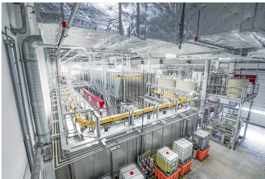
Im chinesischen Taicang hat Brose 2020 eine emissionsfreie Lackieranlage in Betrieb genommen.
